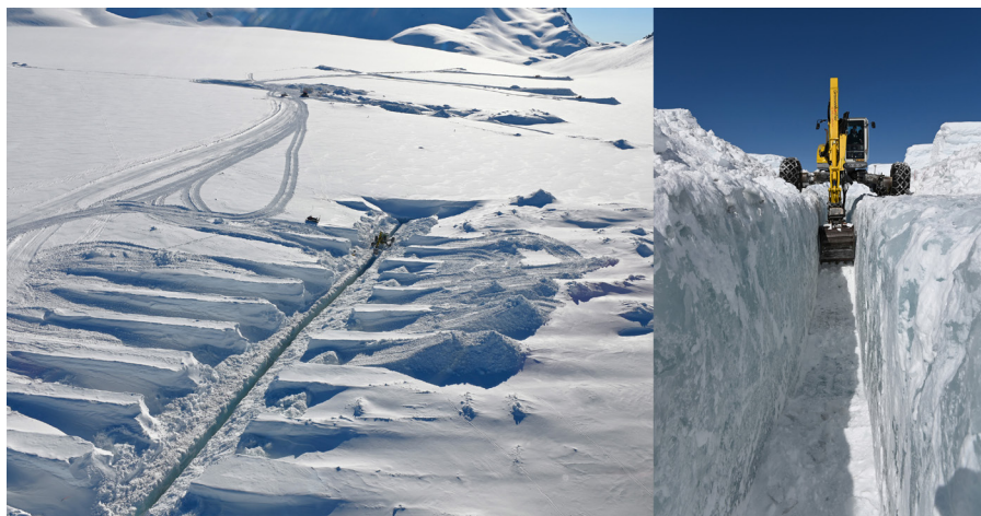
Abbildung 8: Bau des Eiskanals mit dem Schreitbagger (P. Petroni).
