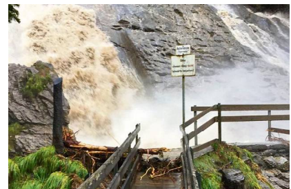
Der Barbarasteg bei den Simmenfällen wurde beschädigt und bleibt vorläufig gesperrt.
