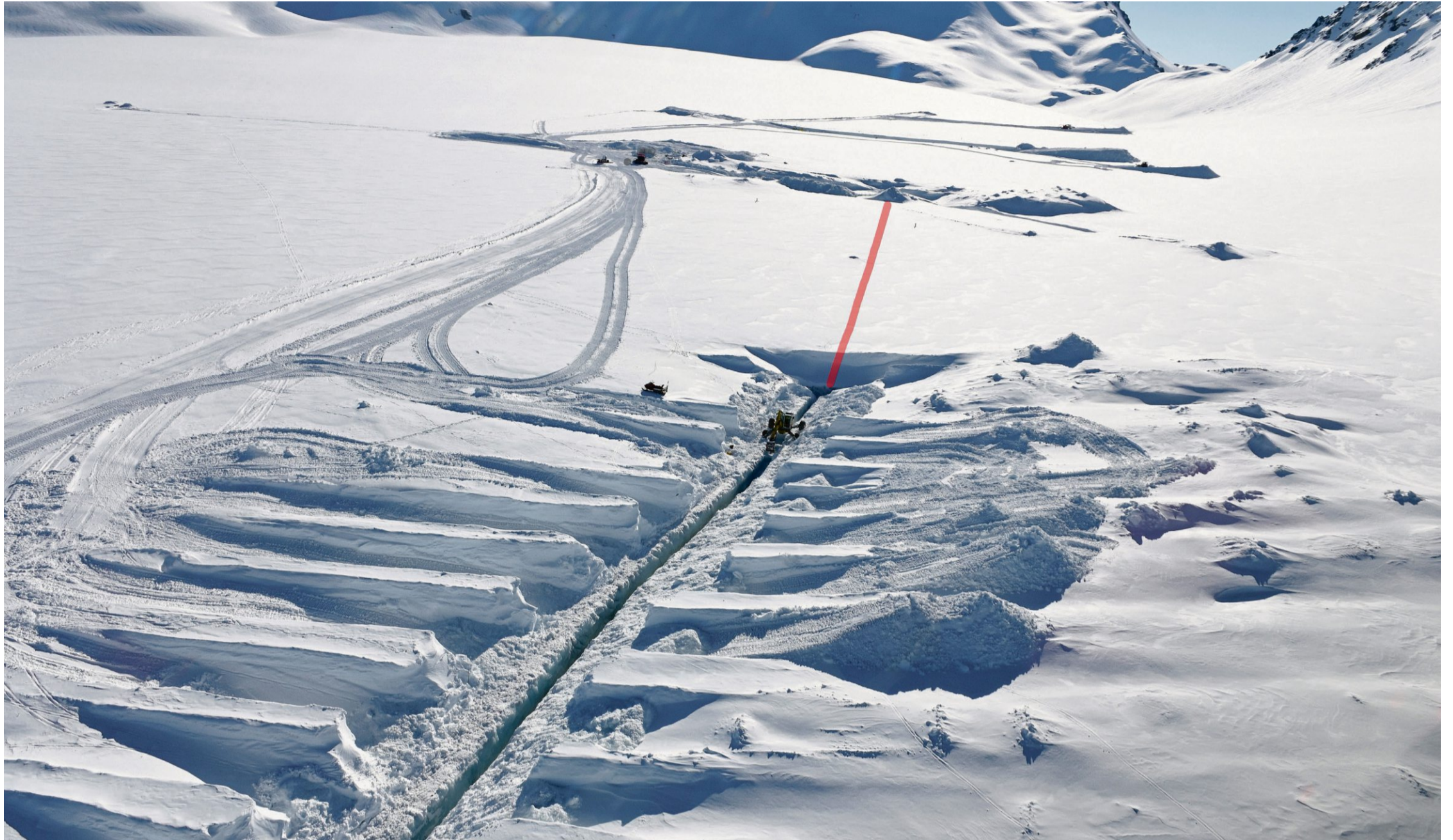
Hier im Vordergrund entsteht der fünf Meter tiefe Eiskanal. Die rot eingezeichnete Linie dahinter zeigt den Verlauf des ersten der vier 200 Meter langen Mikrotunnel unter dem Gletscher hindurch. Fotos: Bruno Petroni
