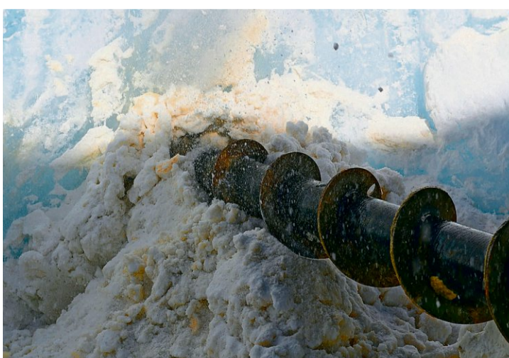
Die Bohrschnecke befördert viel Eisgranulat aus dem Mikrotunnel.
