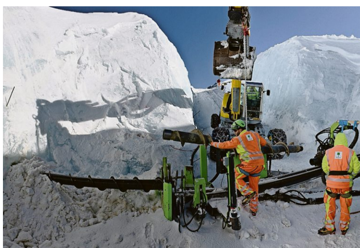
In diesem zehn Meter tiefen Graben erfolgt der Bohrvortrieb.
