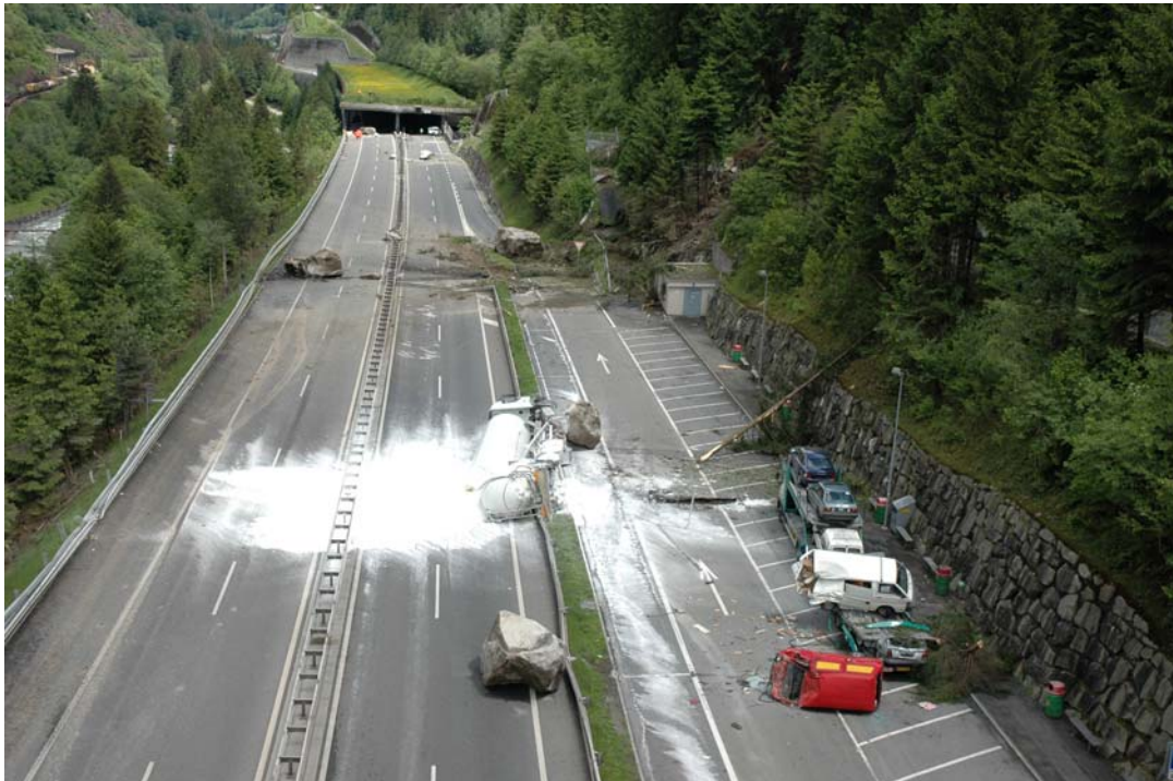
Bild 2: Felssturz bei Gurtellen, 31. Mai 2006. Grossblöcke mit Kubaturen zwischen 6 und 60 m 3 erreichten die Autobahn oder stürzten sogar noch über diese hinaus.
