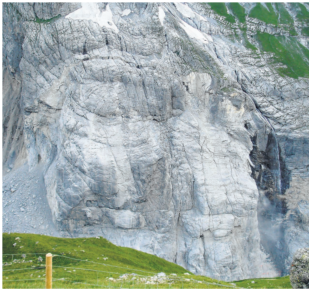
Das Bild links zeigt eine Frontalansicht des absturzgefährdeten Felspakets unterhalb der Schlosslouwina, fotografiert am 4. Juli von der Bäregg aus. Die Felsnase wird begrenzt durch einen grossen bergseitigen Hauptspalt , der sich schon mehrere Meter geöffnet hat. Der rechte Teil der Felswand stürzte am 13. Juli ab.
