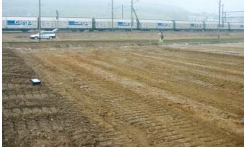
Die Rohplanie nach dem Abhumusieren vor den Pfählungsarbeiten.
