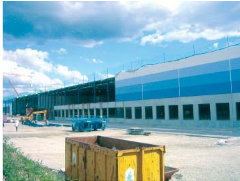
Halle im Bau.
