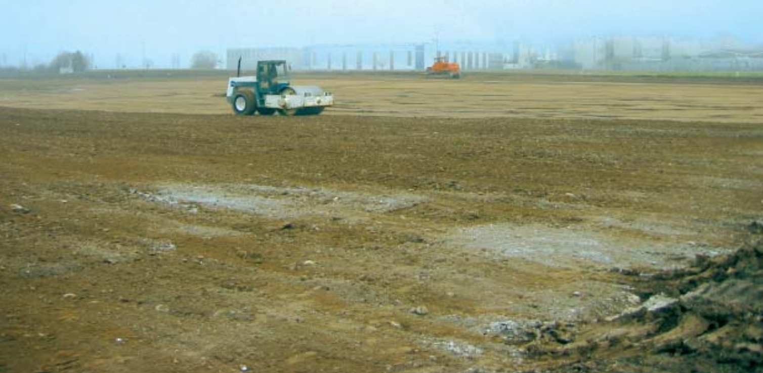
Die Rohplanie nach dem Abhumusieren und Geländeausgleich.
