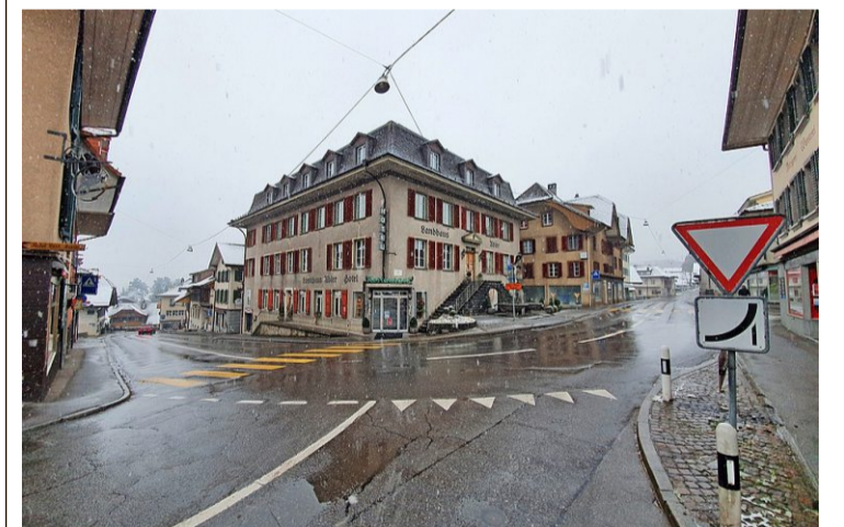
Die Hauptstrasse durch Frutigen, hier die Kreuzgasse, wird saniert. Foto: nik
