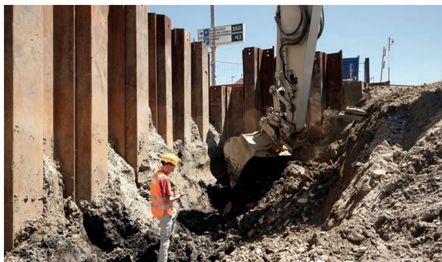
Fachspezialisten begutachten den Schadstoffherd und begleiten den Aushub.
