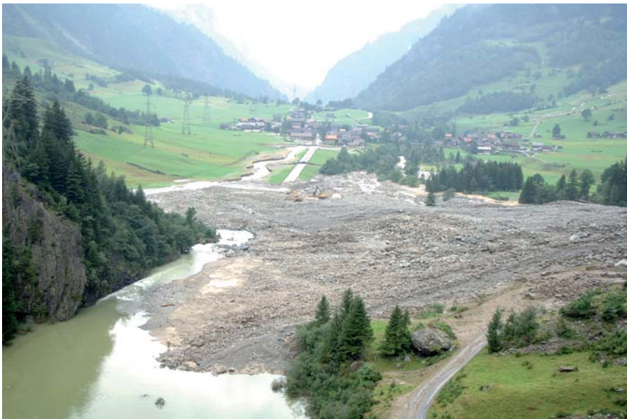
Bild 1. Aufbränden des Murgangs am Felsrücken und Rückstau der Aare (Foto: H.R. Keusen, 24.8.2005).
