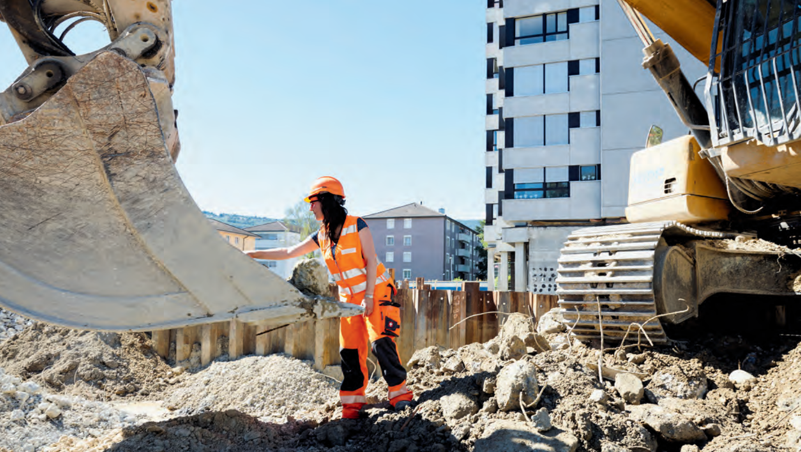
Beurteilung des Untergrundes und Entnahme von Proben im Rahmen eines Aushubs.
