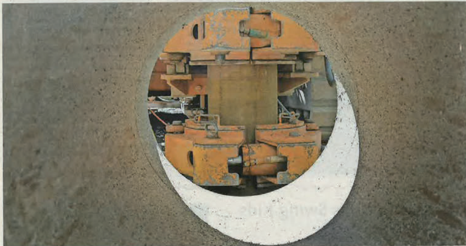
Ein spezieller Blick durch eines der Stabilisierungsrohre auf die Bohrmaschine.
