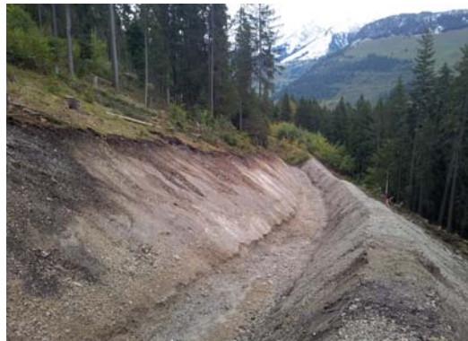
Foto des Schutzdammes oberhalb der Geissegg während der Bauphase im Jahr 2013.
