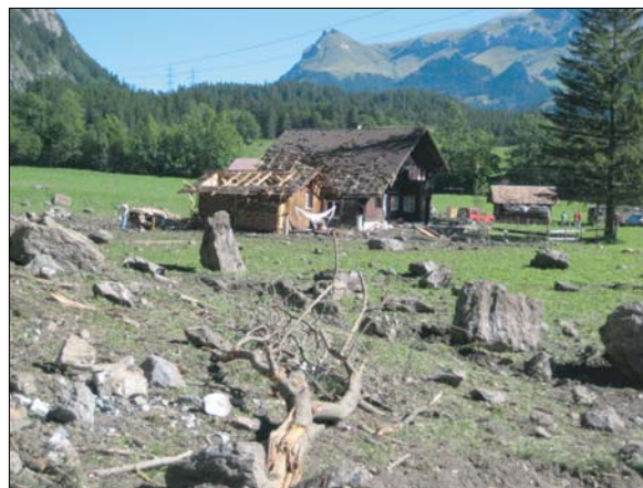
Sturzablagerungen und stark beschädigtes Haus im Hintergrund.
