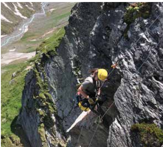
↑ Unser Autor im Gespräch mit Thomas Bickel in dessen Oberstdorfer Heimat. ← Installation einer Messüberwachung zur Prozessbeurteilung im Rahmen der Sicherheitssprengung oberhalb der Läntahütte.
