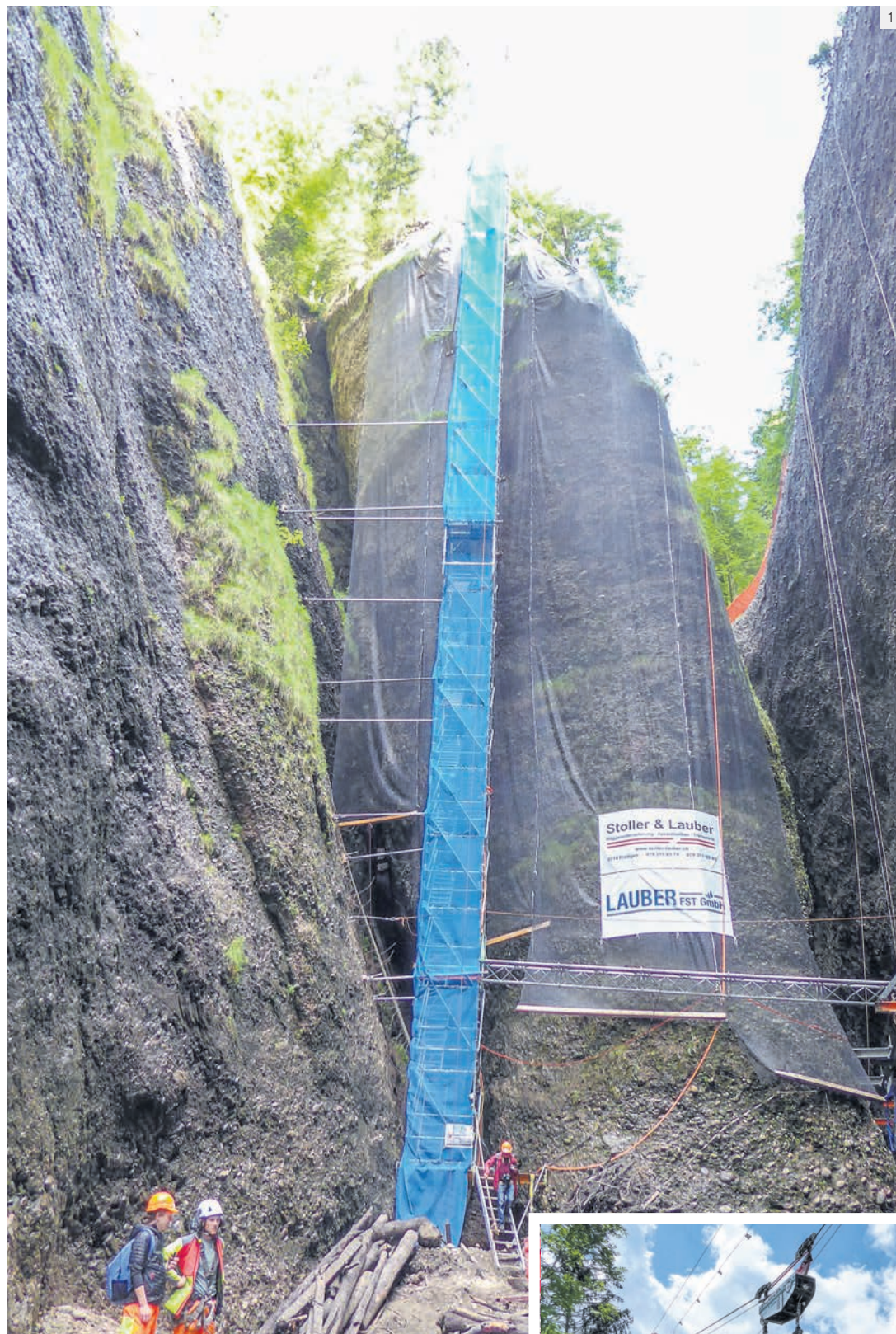
1: Die Treppe im hellblauen Gerüstturm ist Arbeitsweg des Kranführers und Notausstieg zugleich. 2: Die volle Mulde wird zum Umschlagplatz hochgeleitet und dort gekippt. 3: Rudolf Stoller (l.) und Hansjürg Lauber begannen im Herbst mit den Vorarbeiten. 4: Zur Sicherheit mussten erst Steinschlagnetze angebracht werden.
